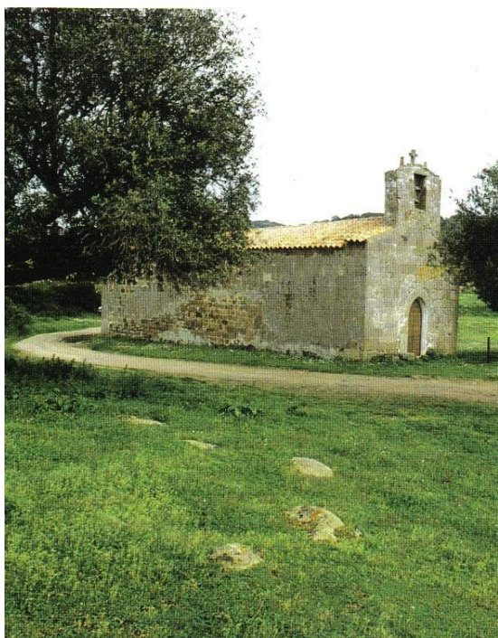
Fig. 14 – La chiesa di Santa Vittoria del Sassu prima dei restauri. Questo edificio viene spesso confuso con la Santa Vittoria di Gavazana, antica parrocchiale del villaggio medioevale di Battana che fino al 1347 sorgeva tra Perfugas e Laerru.
